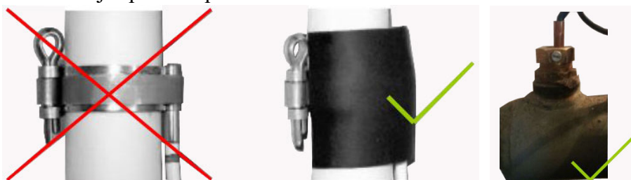
Obr. č. 8 – zapojení teplotních čidel
